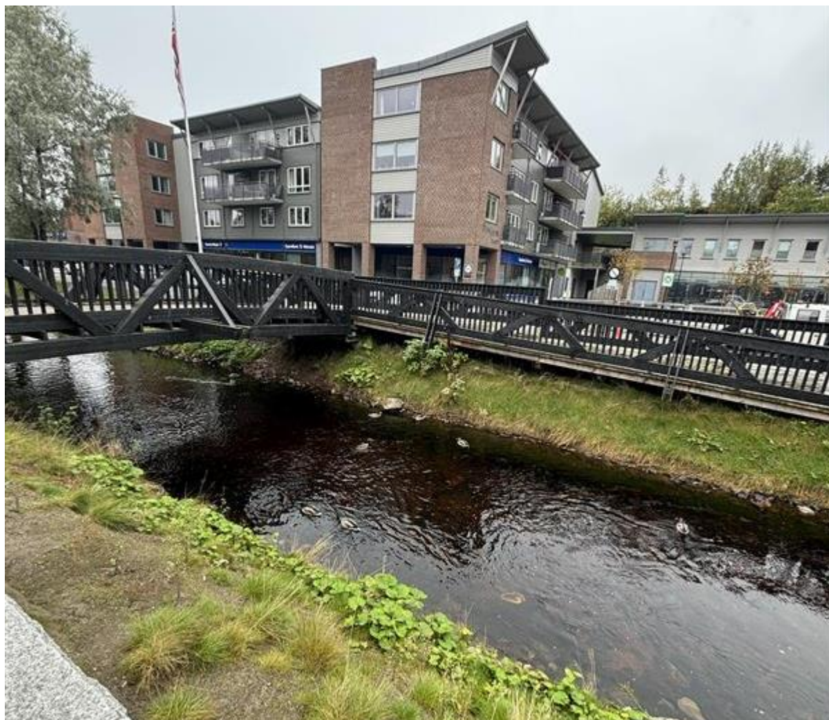
Figur 13. Ørfiskebekken Vågedammen – Nitelva, som renner igjennom Nittedal sentrum.
