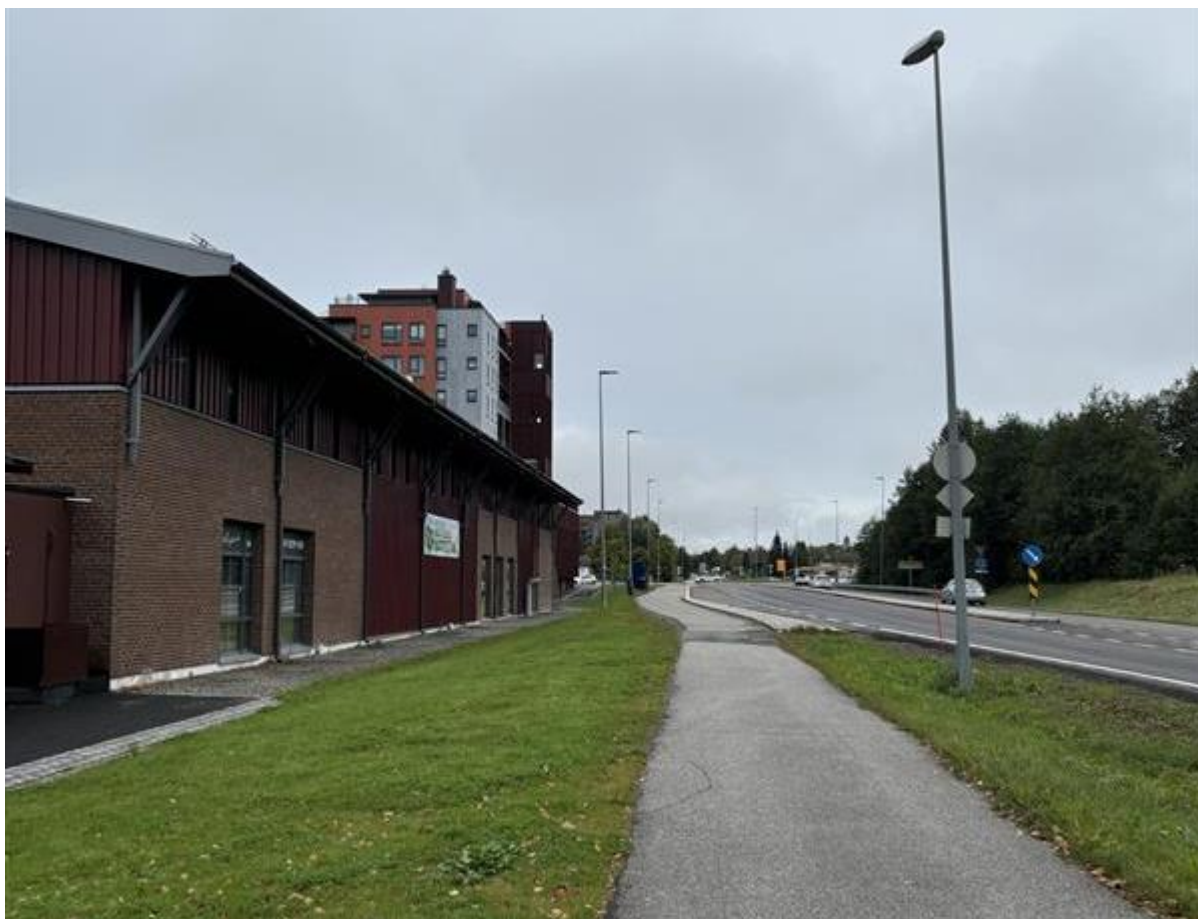
Figur 14. Langs E4, bilde tatt i nordlig retning. Forretning- og boligbebyggelse på venstre side.
